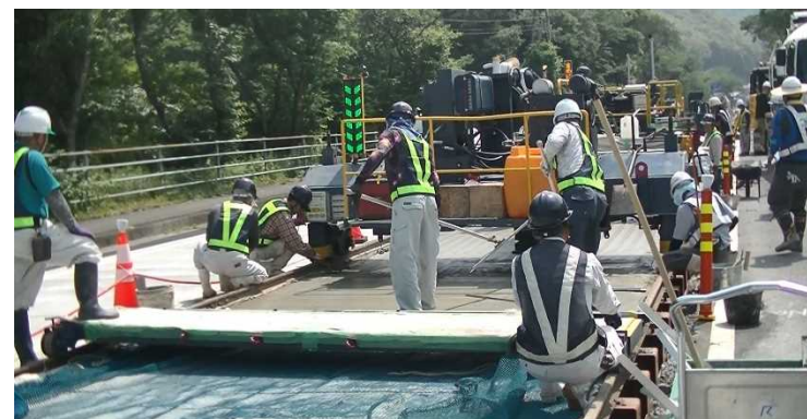
コンクリート舗装の施工事例
