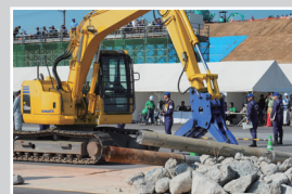
重機によるがれき撤去
