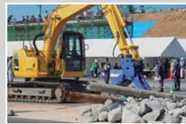
重機によるがれき撤去
