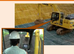
3次元設計データに 基づき建設機械を制御
