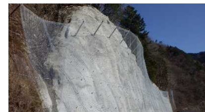
当初工法＋モルタル吹付工（追加対策）
