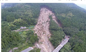
図2 寸断された高速道路
