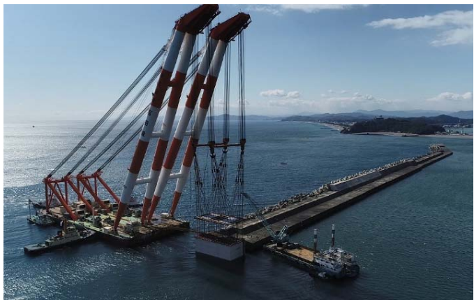
【ケーソン据付状況】
