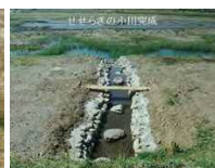
上池 せせらぎの小川完成
