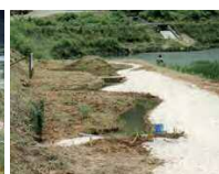
下池 完成したメダカ池
