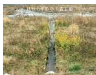
上池 整備前の排水溝
