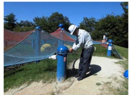
遊具の定期点検の実施
