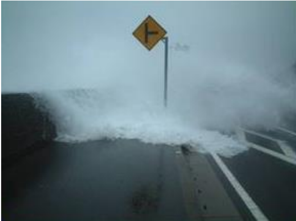
平成16年9月 越波(国道55号 室戸市)
