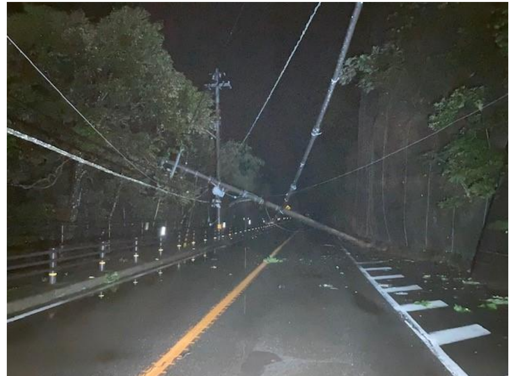
令和6年6月 電柱倒壊(国道32号 三好市)
