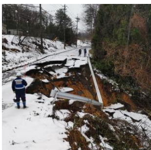
道路被害状況の調査
