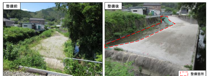
水路の整備（岡花地区）
