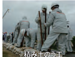
積み土のう工
