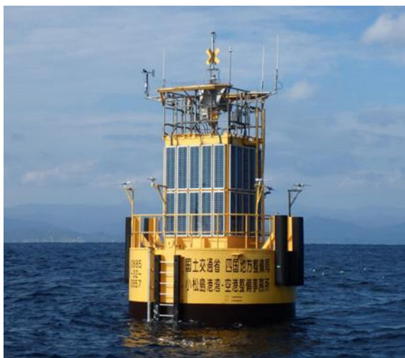
ーGPS波浪計測灯浮標 諸元ー ブイ全高：約18m（喫水線上8m）
