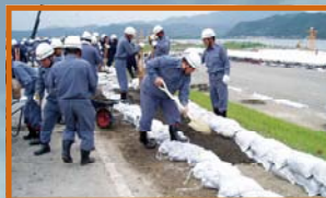
積み土のう工
