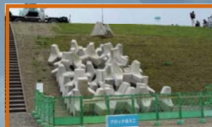
ブロック投入工
