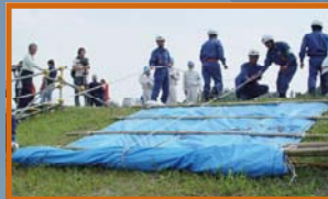
シート張り工
