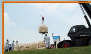
大型土のう工
