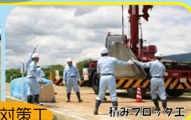
法くずれ対策工
