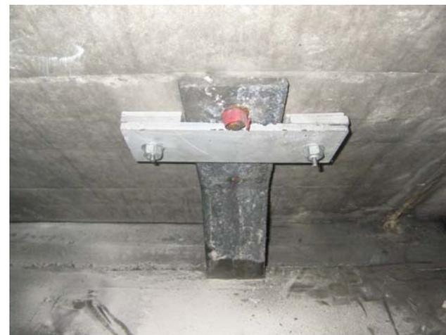
吊金具定着部のコンクリートのうき(19箇所)
