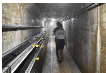
ダム監査廊見学
