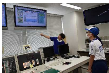
ダム操作室見学
