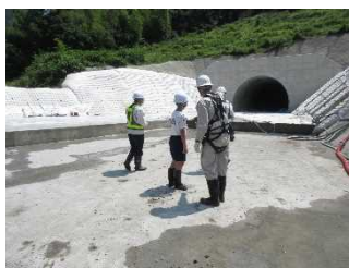
仮排水トンネル見学
