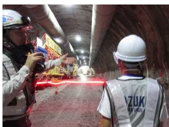
新内海トンネル見学
