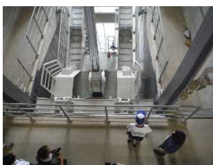
ダムゲート見学
