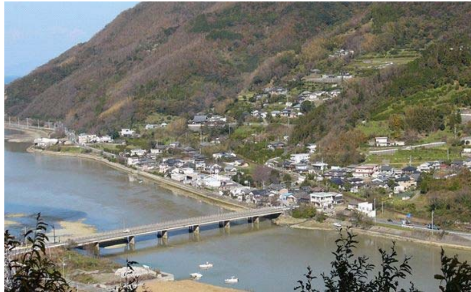
最新の耐震設計、桁下高の確保や橋脚の削減により、橋梁の安全性を高めました。新大和橋両岸に、旧大和橋の親柱を移設しました。
