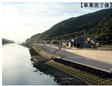
浸水を防ぐために、宅地嵩上げを行いました。
