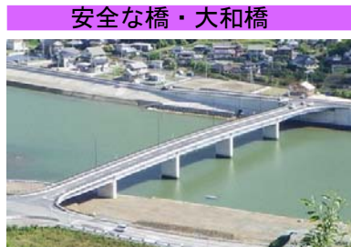
最新の耐震設計、桁下高の確保や橋脚の削減により、橋梁の安全性を高めました。新大和橋両岸に、旧大和橋の親柱を移設しました。
