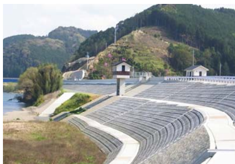
堤防・護岸(管理者:国土交通省)
