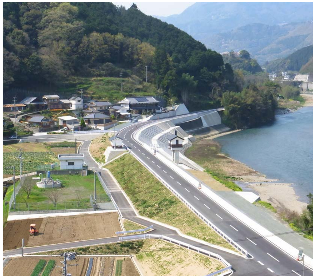
肱川左岸多田地区(平成22年4月撮影)
