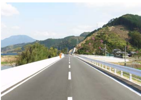
主要地方道長浜中村線(管理者:愛媛県)
