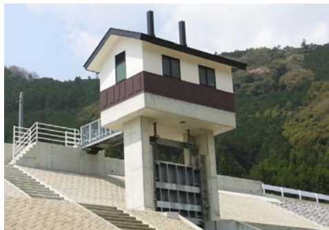
多田樋門(管理者:大洲市)
