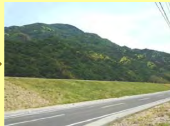
完成 (令和元年5月撮影)
