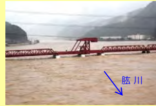
平成30年7月豪雨(長浜大橋を望む)
