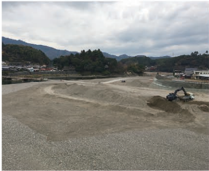
堆積土砂撤去
