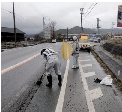
道路パトロール状況(路面の補修作業)
