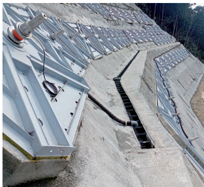
法面の防災対策工事(喜多郡内子町)
