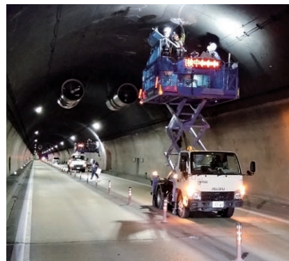
トンネル点検状況(宇和島市藤江)
