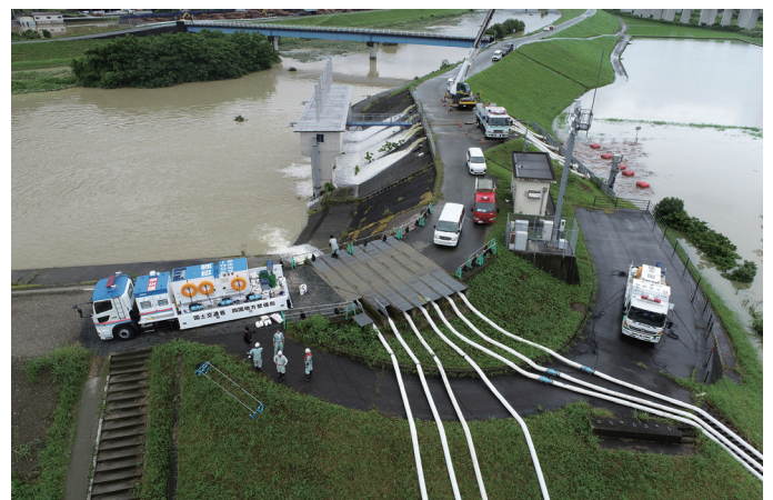
災害対策用機械の活動状況
