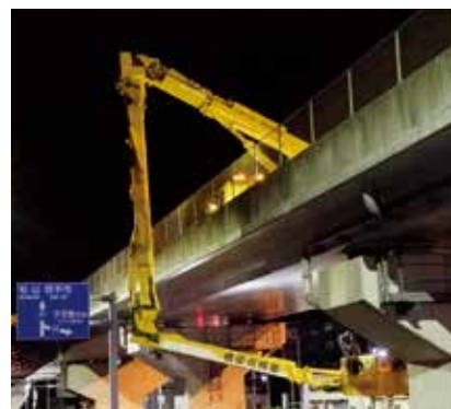
橋梁点検状況(宇和島市高串)
