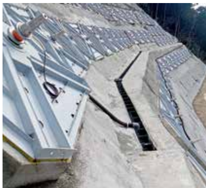
法面の防災対策工事(喜多郡内子町)
