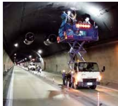
トンネル点検状況(宇和島市藤江)
