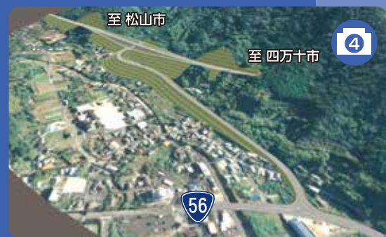
内海IC(仮称)付近
