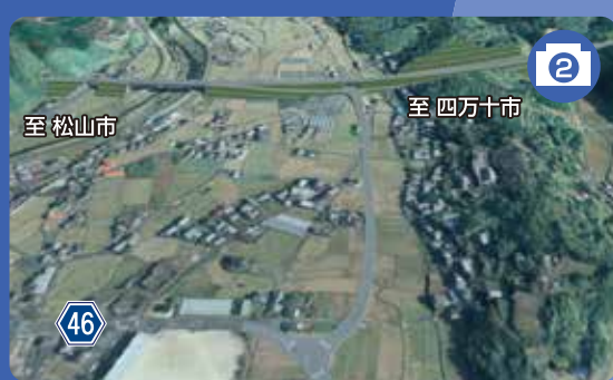
城辺IC(仮称)付近
