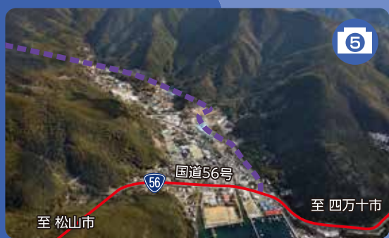
内海IC(仮称)付近
