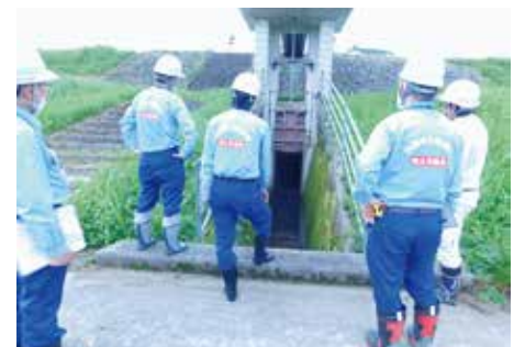
河川管理施設等の点検
