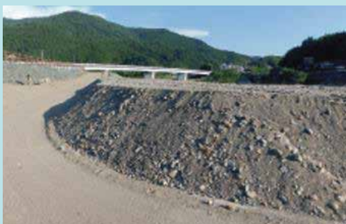
河道内に堆積した土砂の撤去
