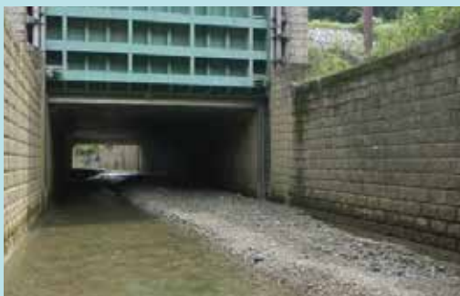
樋門に堆積した土砂の撤去
