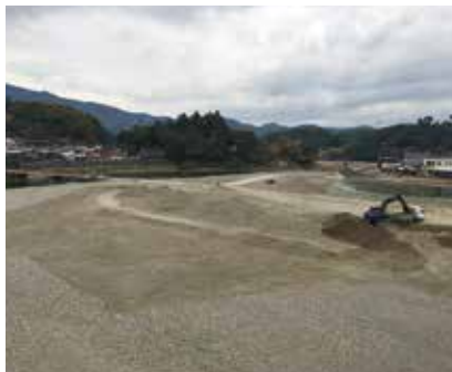
堆積土砂撤去
