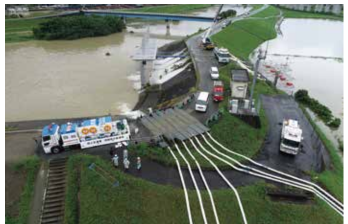
災害対策用機械の活動状況
