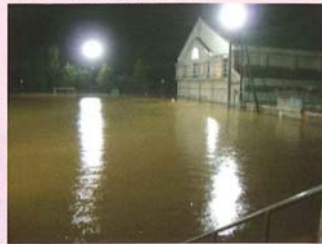
③ 久米小学校浸水状況
