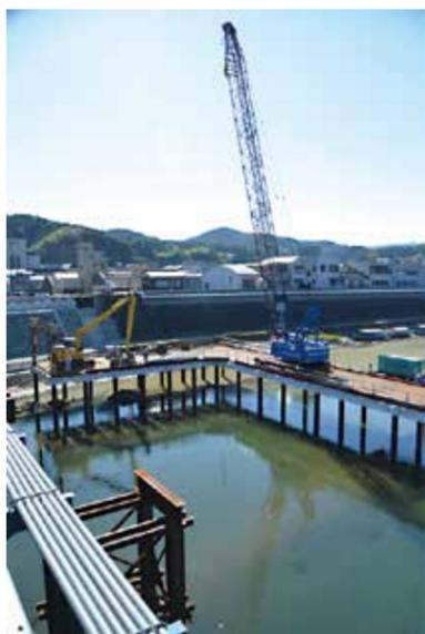
中央建設株式会社は、地元大洲を拠点として、総合建設業（土木工事業、建設工事業、産廃・一般廃棄物業（産業廃棄物収集運搬、中間処理・リサイクル・最終処分）、解体工事業、建設機械や産業廃棄物等の運送業を展開しています。このたび、肱川橋の橋脚を新たに建設するための架設橋整備を担当させていただきましたこととなり、令和元年9月上旬より工期に入りました。架設橋とは工事用道路のことで、建設機械の作業スペースや工事用車両の通行、資材を置くスペースなどを確保するためのものです。今回の工事では、新肱川橋に設置される3つの橋脚のうち、肱南側からの橋脚2基に関わる架設橋を施工します。
