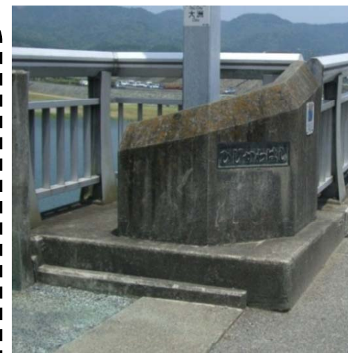
現在の親柱 (1.0m×1.0m, コンクリート製)
