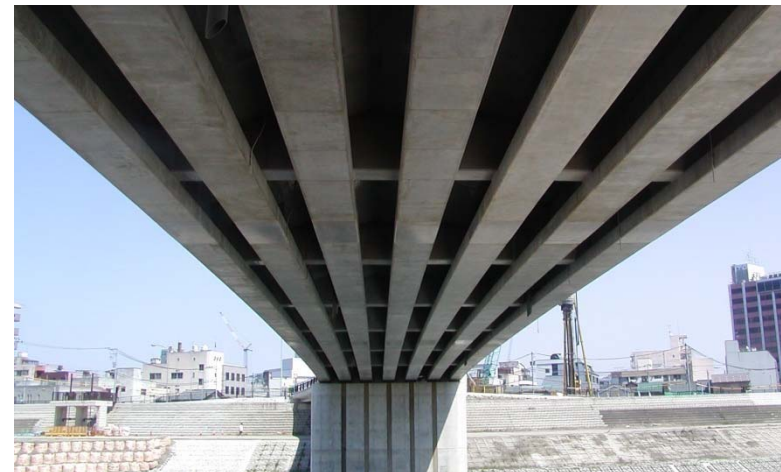
桁下面がすっきりとした例（プレビーム桁）
