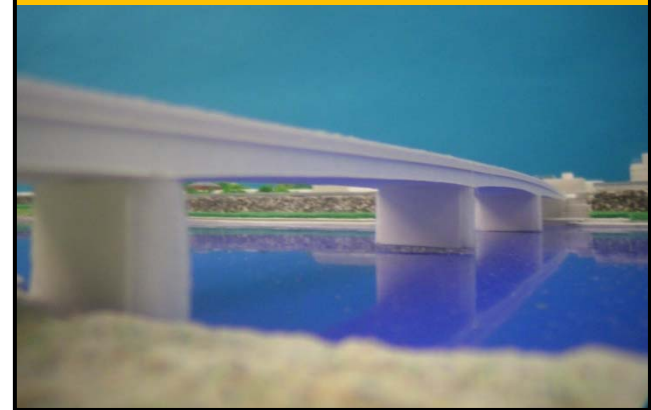
右岸下流より
