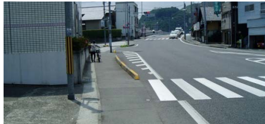
右岸歩道整備状況（橋梁側）
