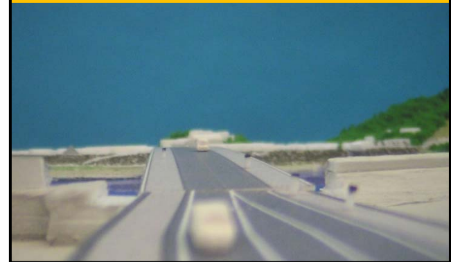
左岸側の道路より
