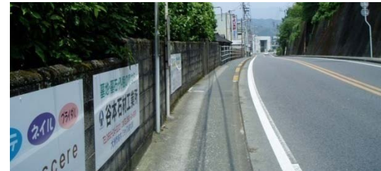
右岸歩道整備状況（JR側）
