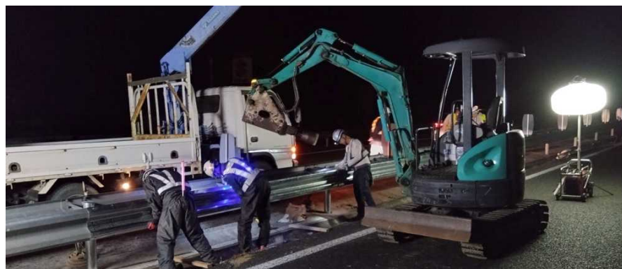
道路附属物復旧作業
