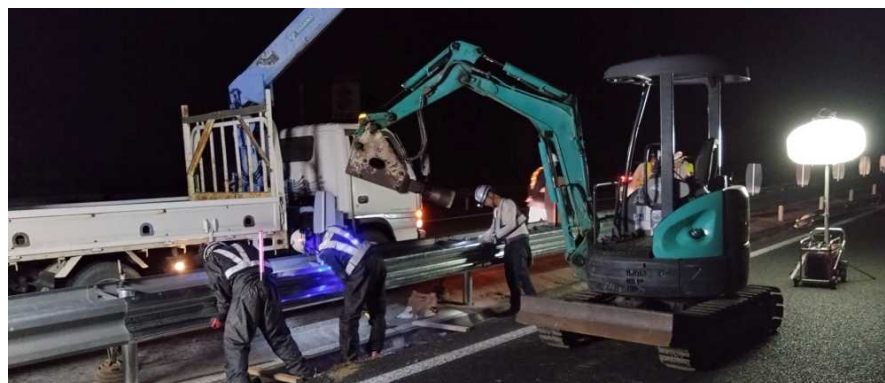
道路附属物復旧作業
