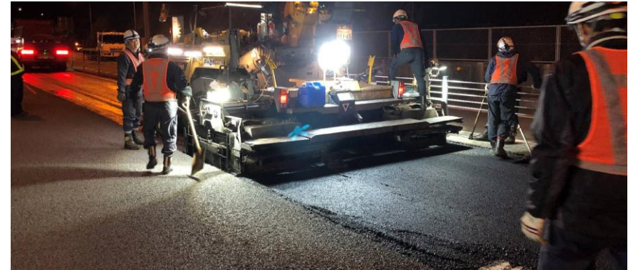
舗装修繕作業
