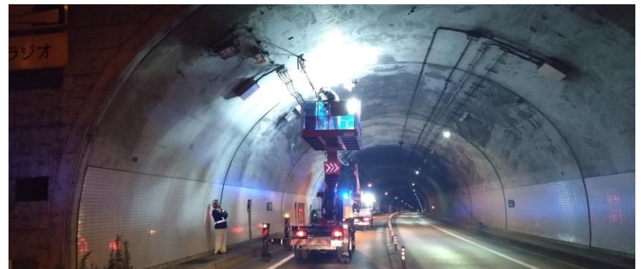
トンネル照明LED化作業
