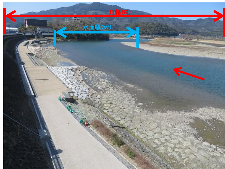
肱川橋上流(肱川橋右岸より撮影)
