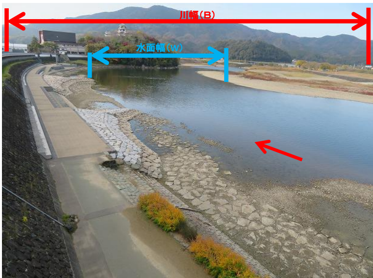
肱川橋上流(肱川橋右岸より撮影)
