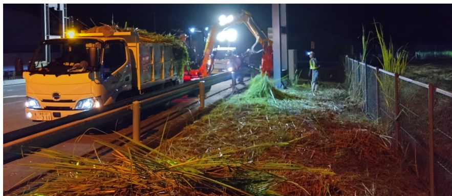
除草・伐採作業
