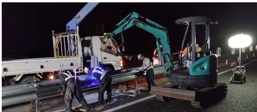
道路附属物復旧作業
