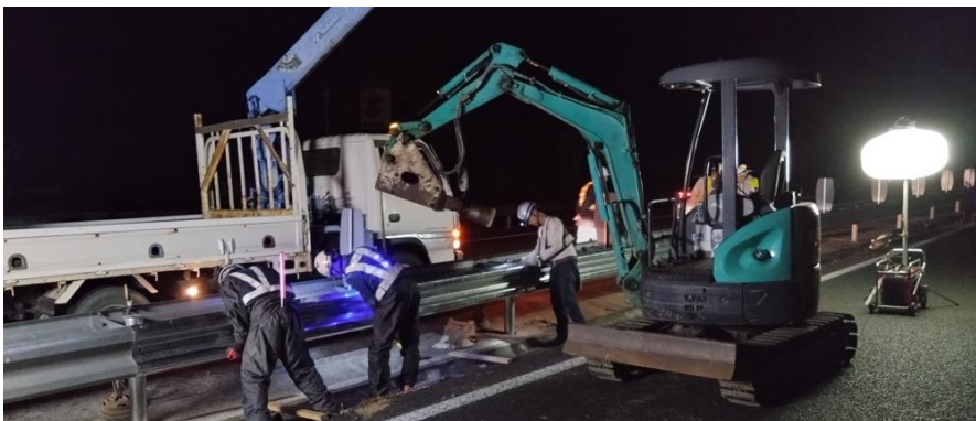
道路附属物復旧作業
