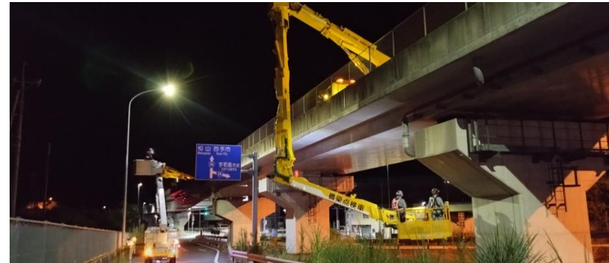
橋梁の点検作業
