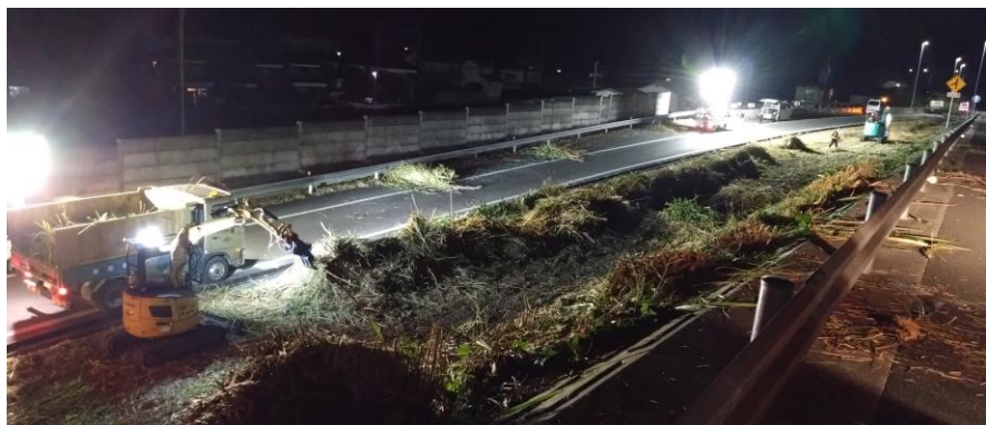
除草・伐採作業
