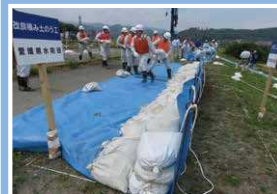
改良積み土のう工
