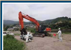
道路啓開訓練
