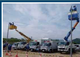
ライフライン復旧訓練
