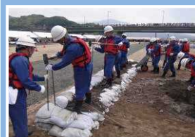
積み土のう工
