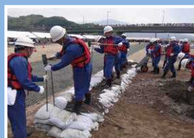
積み土のう工
