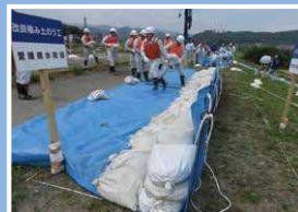
改良積み土のう工
