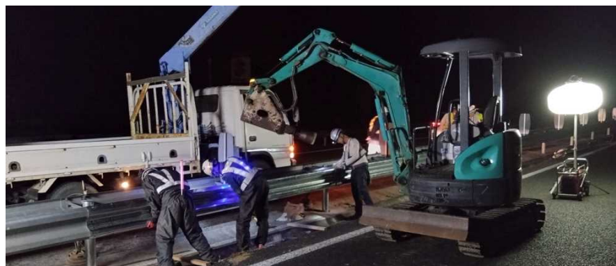
道路附属物復旧作業
