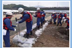
積み土のう工
