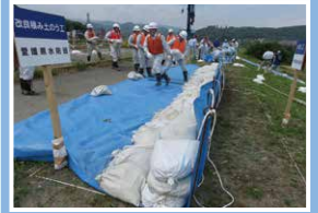
改良積み土のう工
