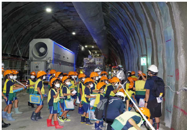
トンネル坑内での説明状況3
