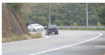
一般国道56号の急カーブ (高知県宿毛市野地)
