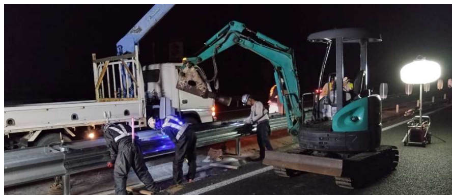
道路附属物復旧作業
