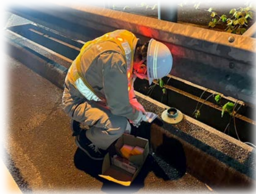
道路附属物の設置・復旧
