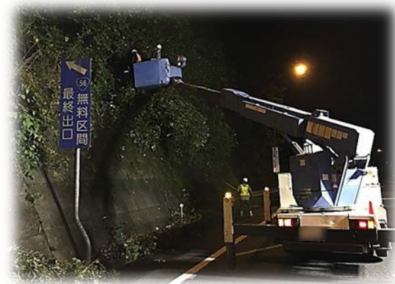
道路除草作業
