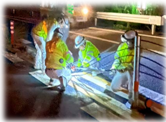
防護柵の復旧
