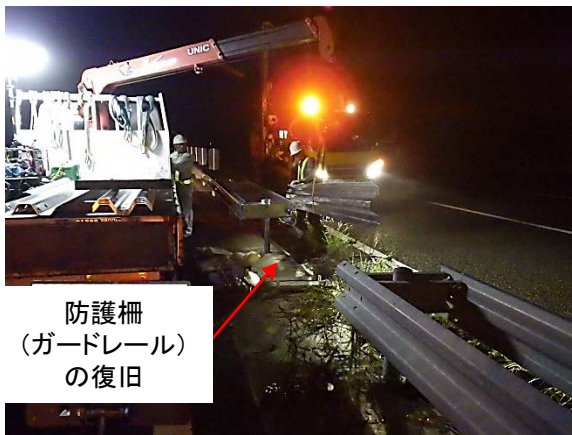
道路附属物の復旧
