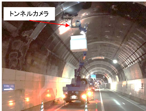
トンネルカメラの点検
