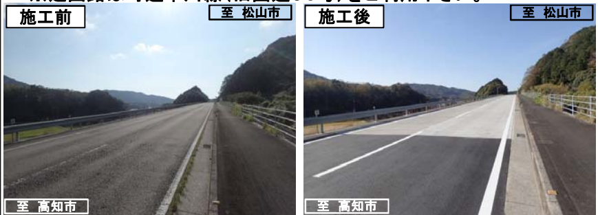
令和4年度工事箇所(コンクリート舗装)
