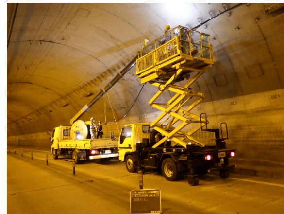
照明設備更新作業
