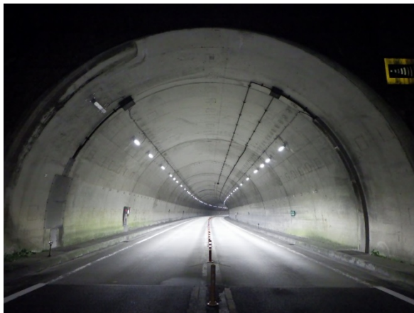
照明設備更新後
